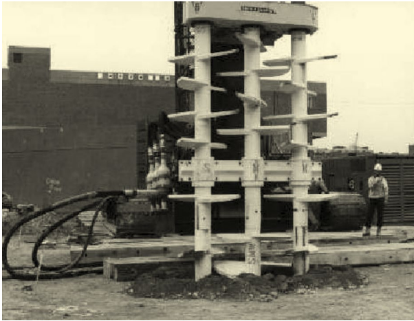
Şekil 1.6. İki ve üç şaftlı sistemler
