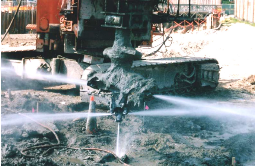
Şekil 1.11. WJE sisteminde kullanılan tipik bir uç (FHWA, 2013)
